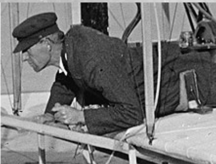
control de vuelo por flexión de las alas (sin alerones)
