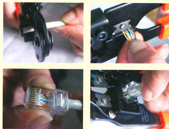
Figura 6.45. Preparación de un conector RJ-45 macho.
