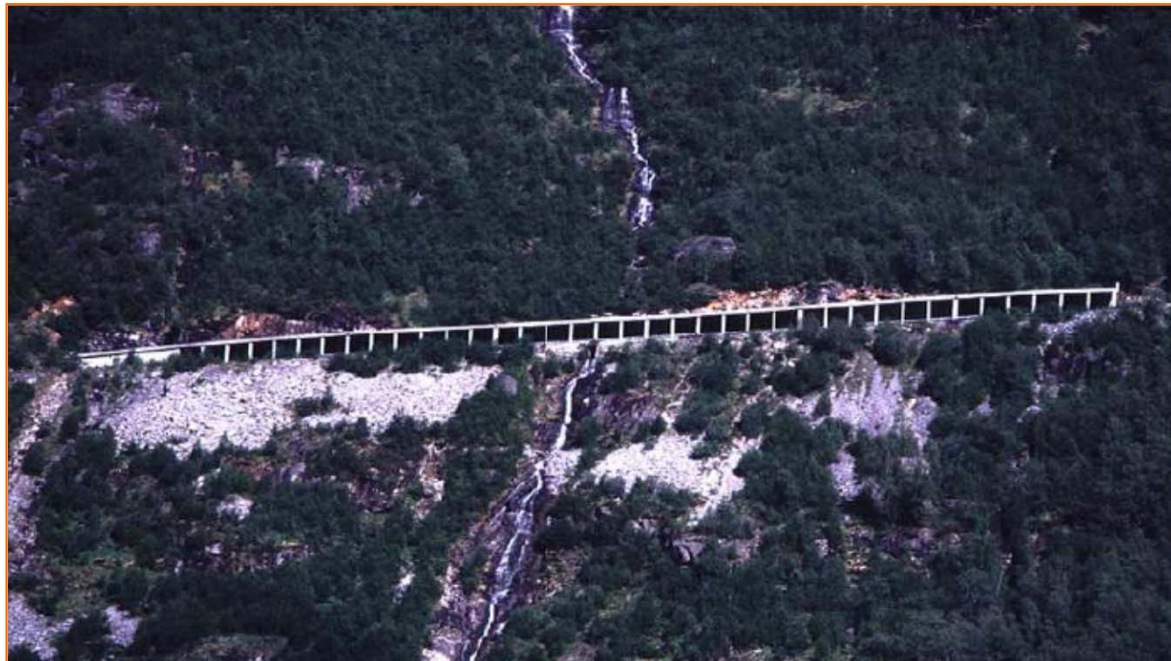
Cubierta en Noruega
