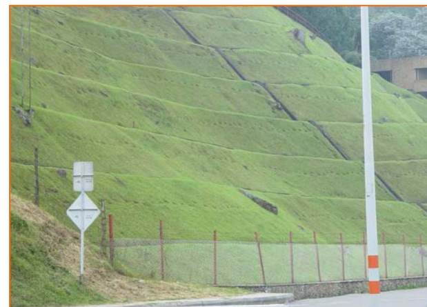
Estructura de muro con geomalla
