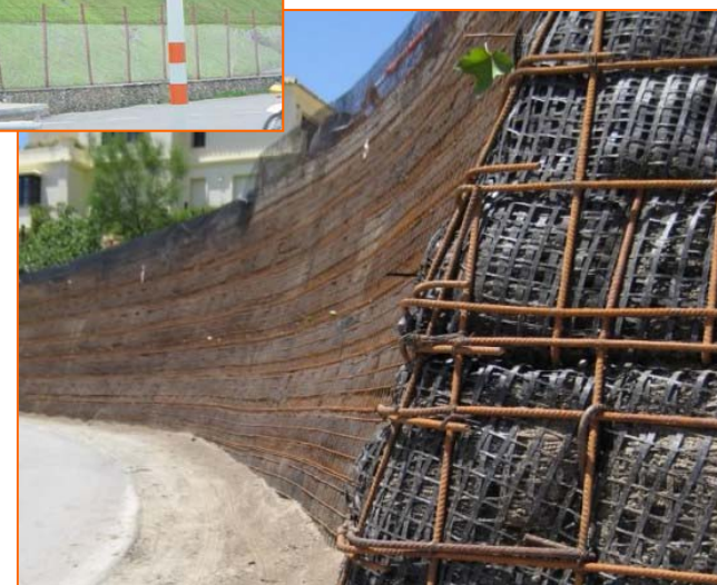
Estructura de muro con geomalla
