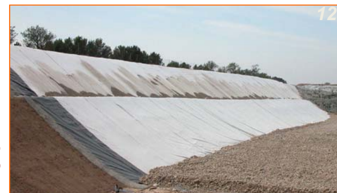
Geotextil bajo Rip-Rap
