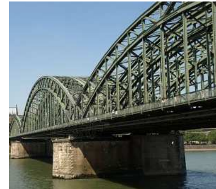
Puente de acero pintado
