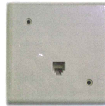
Figura 7.60. BAT del servicio de telefonía.
