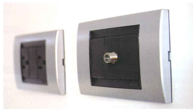
Figura 7.15. BAT para la red de cables coaxiales.
