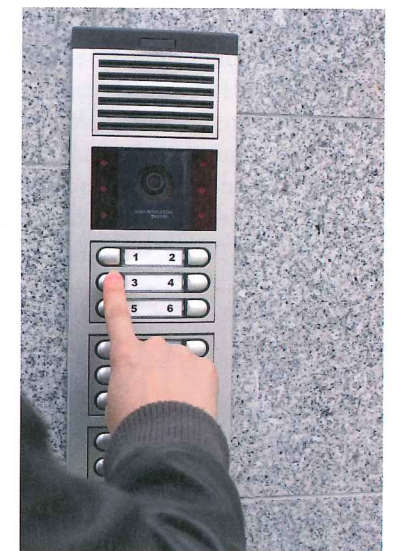
Figura 9.15. Llamada desde la placa de calle.
