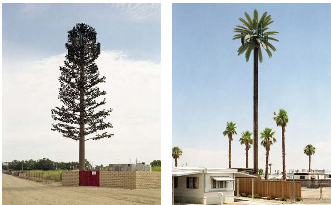
FIGURA 10.1: POSTES DE TELECOMUNICACIONES CAMUFLADOS COMO ÁRBOLES.
