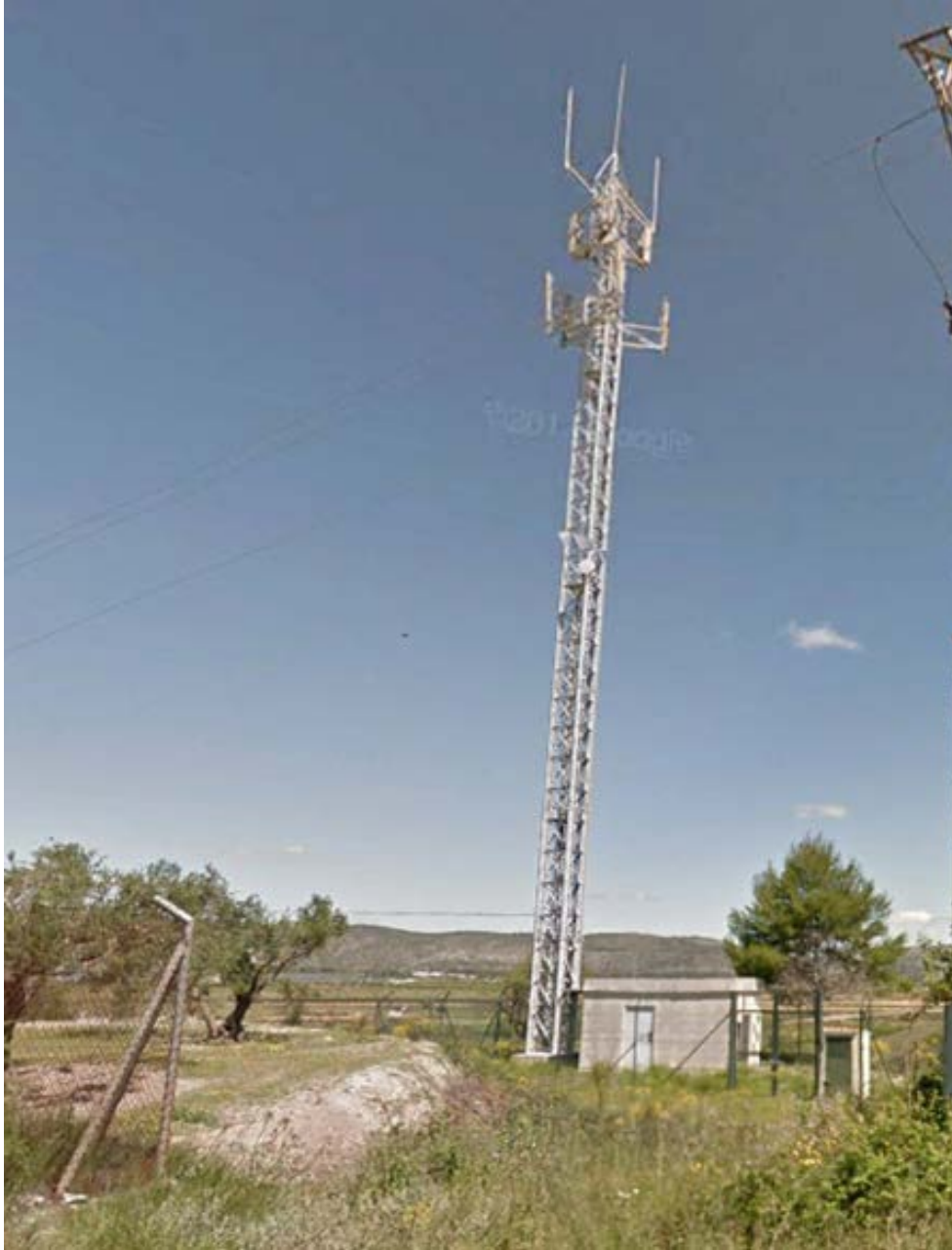
FIGURA 4.7: TORRE DE TELECOMUNICACIONES DE BENISSUERA.
