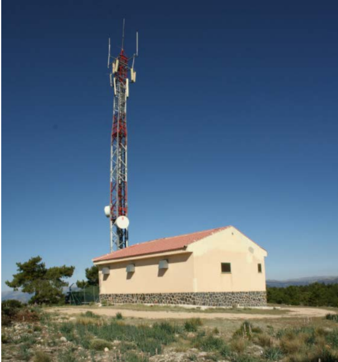
FIGURA 4.5: TORRE DE TELECOMUNICACIONES DE TORRATER.
