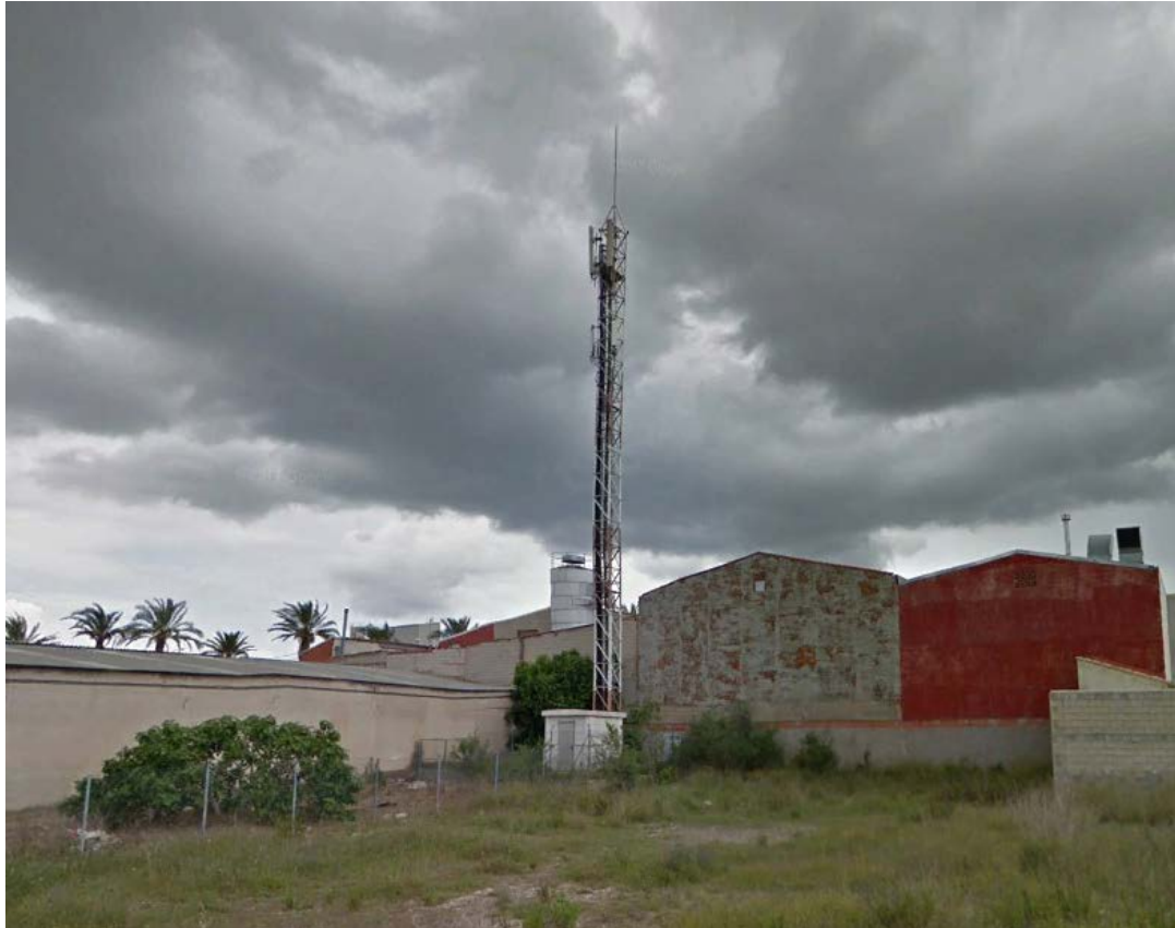
FIGURA 4.9: TORRE DE TELECOMUNICACIONES DE BENIGÀNIM PAS FORCALL.
